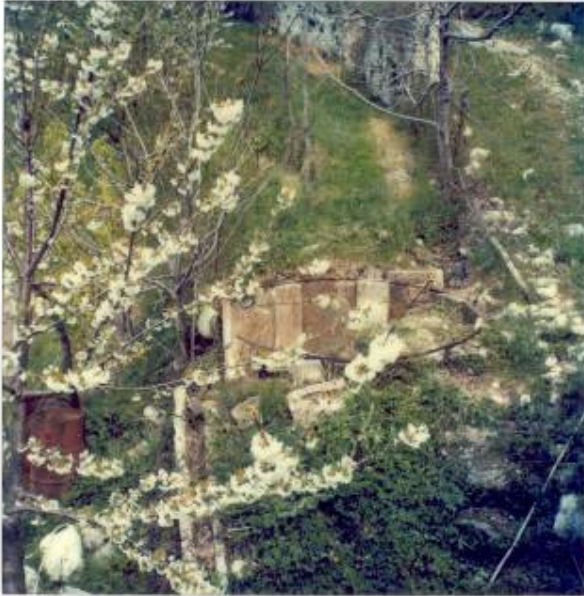
Fig. 17 - La cisterna ottagonale
